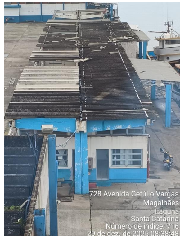
Figura 1 e 2 – Avarias na cobertura das edificações do Porto de Laguna
