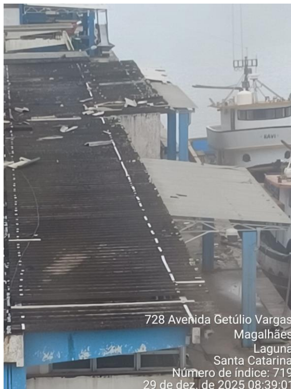
Figura 1 e 2 – Avarias na cobertura das edificações do Porto de Laguna
